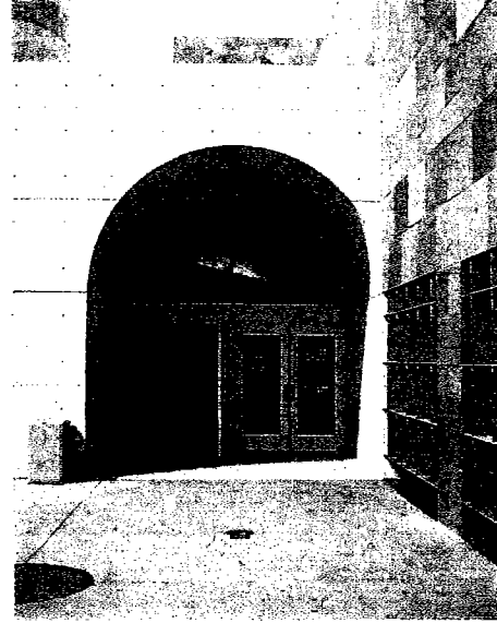
صورة (٣٦٣): مدخل مكتبة عامة لاحظ جعل القوس الأعلى للمدخل عريضاً للتخفيف من تغلغل أشعة الشمس إلى منطقة المدخل
